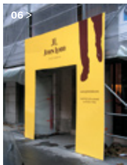
06 > У вас затеяли ремонт фасада? Это прекрасный повод обратиться на себя внимание! Вход в обувной бутик John Lobb в Париже
